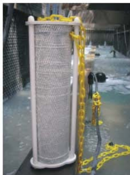
電極放入冷卻水塔內
