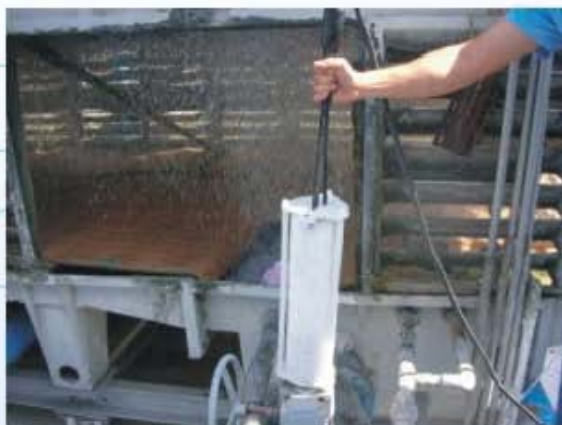
電極放入冷卻水塔內
